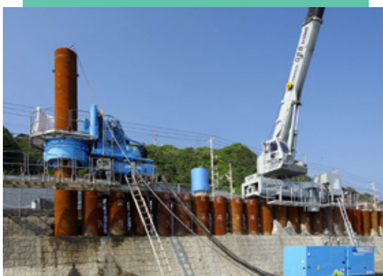
使用螺旋桩机进行堤坝加固工作
