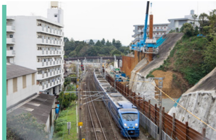
螺旋钻机进行挡土墙施工
